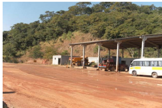
Figura 22 – Pátio de manobra de veículos e oficina
