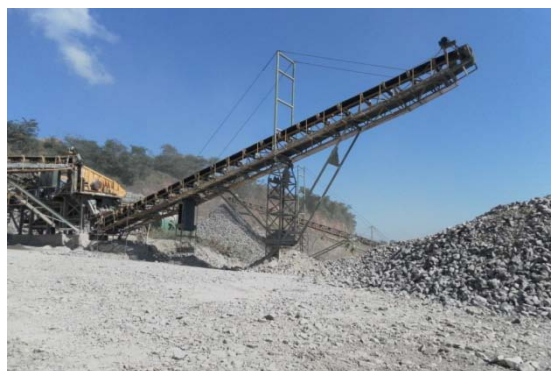
Figura 26 – Visão parcial da usina de britagem
