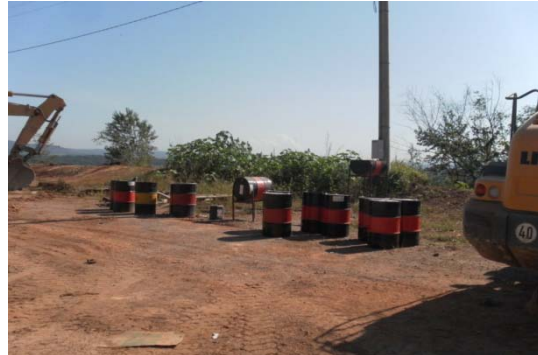
Figura 18 – Tambores com combustível próximos a oficina
