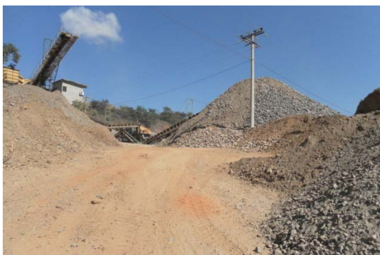
Figura 25 - Acesso a usina de britagem
