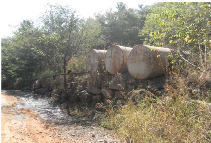
Figura 31 – Tanques de armazenamento e abastecimento de água
