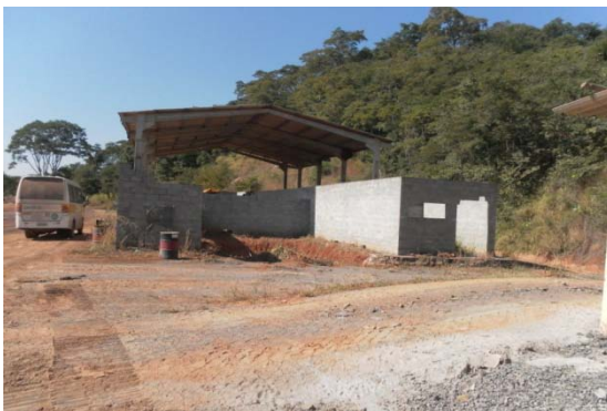
Figura 21 – Visão Lateral da oficina de veículos
